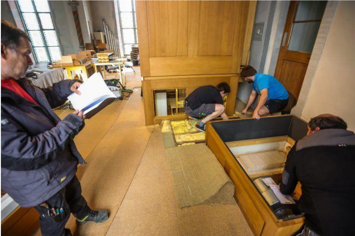
Niklas Marquard (in der Mitte des Bildes im schwarzen T-Shirt) hilft den Elektrikern bei der Arbeit
